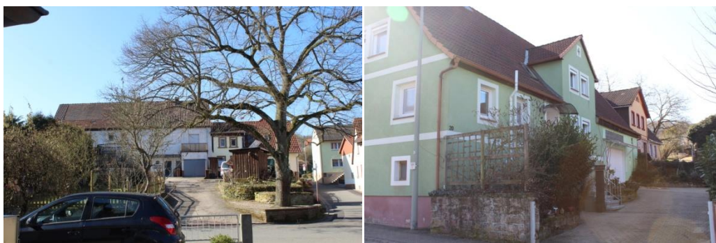
Foto: Einfirstanlagen, traufständig zurückgesetzt, giebelständig Quelle: Eigene Aufnahmen
