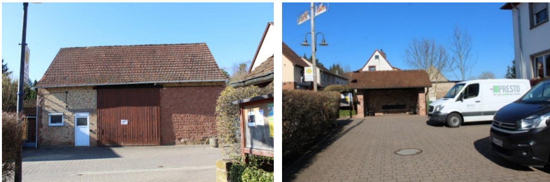
Abbildung: Beispiele typischer Dachformen und -materialien (hier: Doppelmuldenfalzziegel und Bieberschwanzziegel) Quelle: Eigene Fotografien
