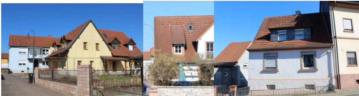
Abbildung: Historische Satteldachgaube, Schleppdachgaube Quelle: Eigene Fotografien
