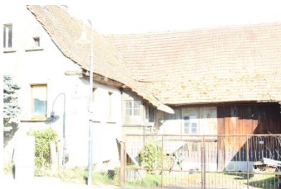
Foto: ehemaliges Wirtschaftsgebäude Quelle: Eigene Aufnahme
