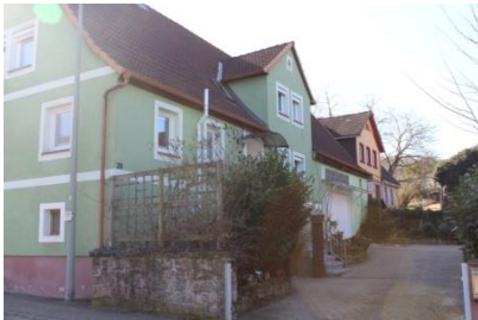
Abbildung: Zwerchhaus / Zwerchgaube Quelle: Eigene Fotografien
