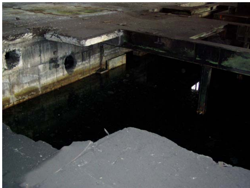
Foto 3 + 4: Hydraulikkeller Bereich Formerei, gefüllt mit Wasser
