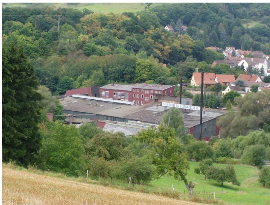
Foto 1: Werksgelände Gienanth, Winnweiler- Hochstein, Blick nach Westen
