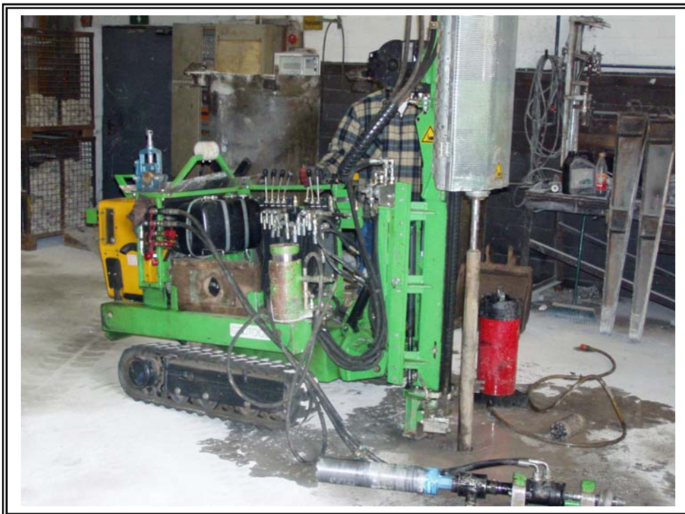
Foto 5: Bohrarbeiten mit der Bohrrampe
