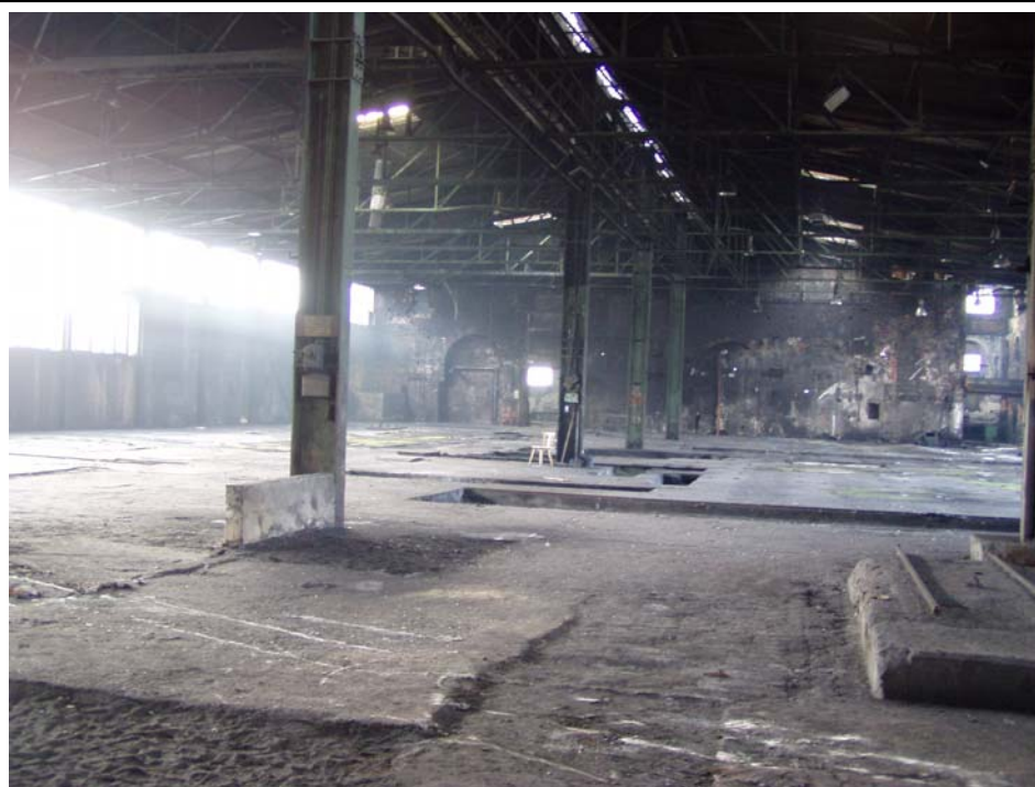
Foto 2: Bereich Schmelzen und Formerei, Blick nach Südwesten
