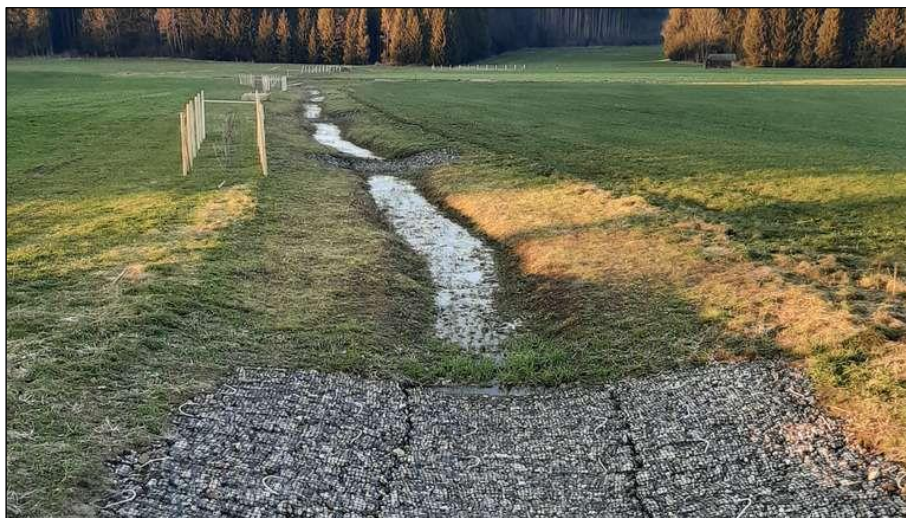
Abb. 19: Verzögerung der Abflussgeschwindigkeit entlang einer begrünten Abflussrinne mittels Einbau von Steinmatratzen (Quelle: OVB 2023)
