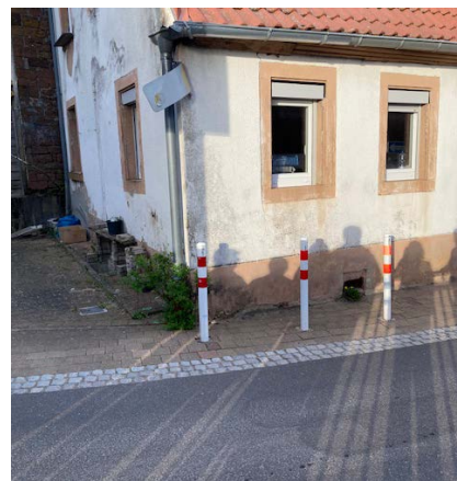
Verengung Gehweg Donnerberger Straße
