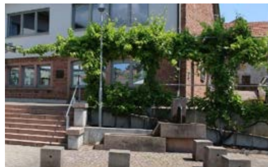
Fassadenbegrünung mit echtem Wein
