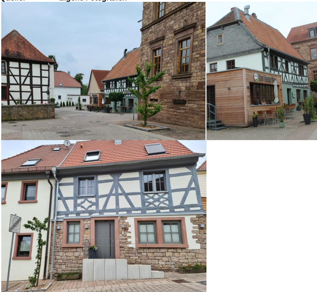
Abbildung: Fachwerkfassaden Quelle: Eigene Fotografien
