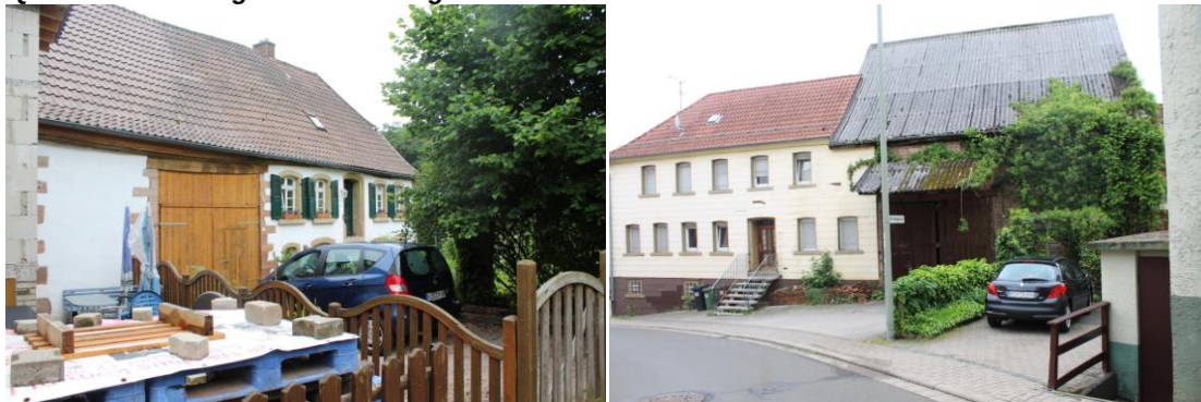
Abbildung: Fassadengliederung bei Einfirstanlagen Quelle: Eigene Fotografien
