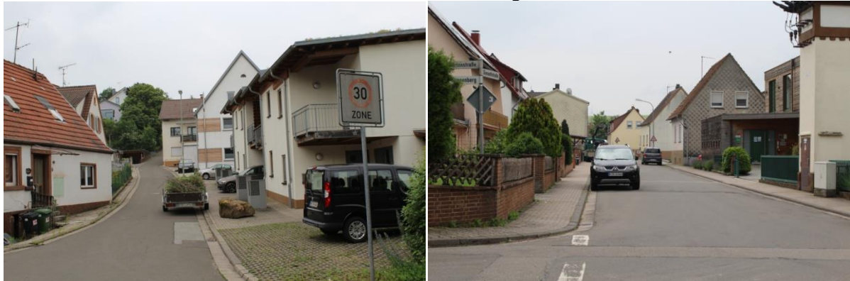
Foto: 30-KMZone, Gienanthstraße in Imsbach im Trennsystem
