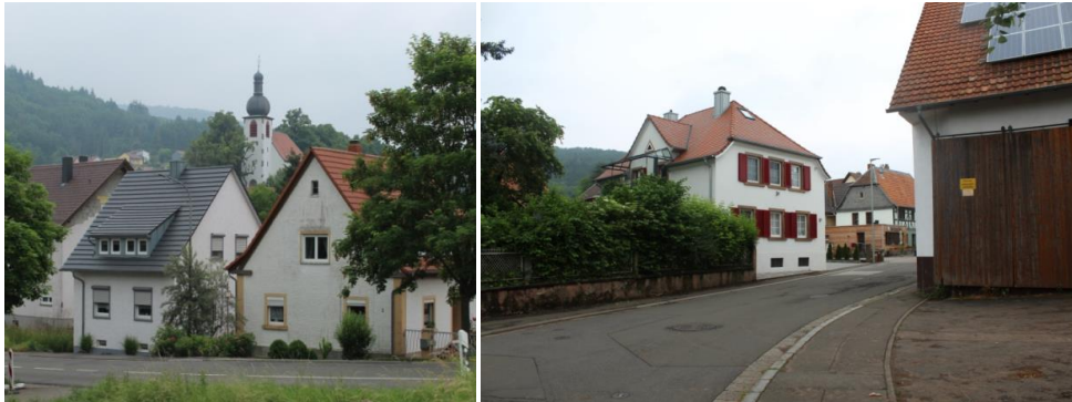
Abbildung: verputzte Gebäude Quelle: Eigene Fotografien
