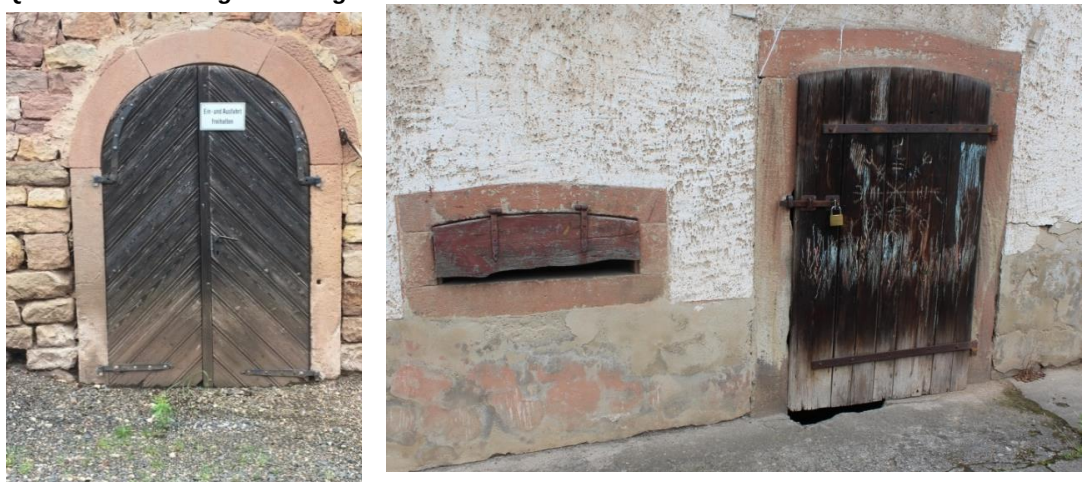
Abbildung: Kellertüren Quelle: Eigene Fotografien
