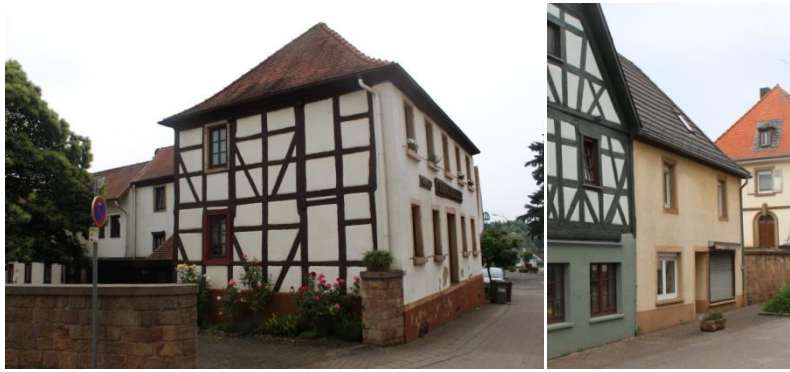
Abbildung: massive Frontwand, seitlich Fachwerkwand, verputztes Fachwerk Quelle Eigene Fotografien
