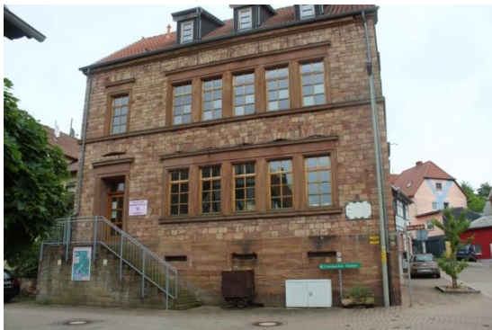
Fotos: ehemaliges Schulhaus
