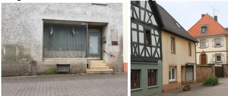
Foto: Teilleerstand ehemalige Ladennutzung
