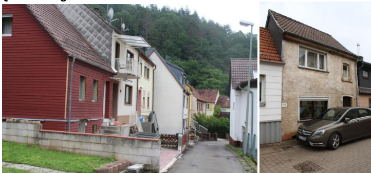
Fotos: Arbeiter- und Tagelöhnerhäuser-Struktur Quelle: Eigene Aufnahmen
