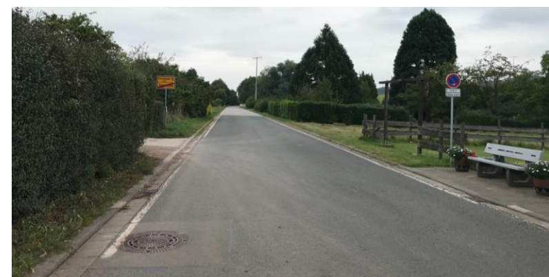
Fehlender Radweg entlang der L394
