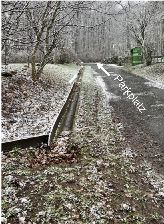
Abbildung 32: Oberflächenentwässerung mit Rinnen
