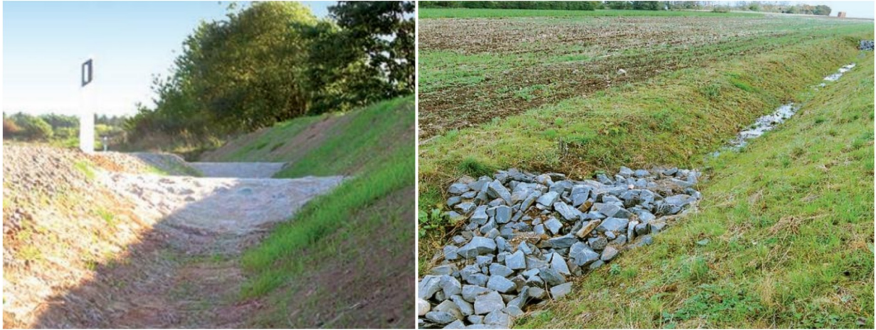
Abbildung 25: Beispiele: Mulden-Kaskaden-Systeme (Quelle: Niederschlagsentwässerung von Verkehrsflächen, umwelt.nrw.de)
