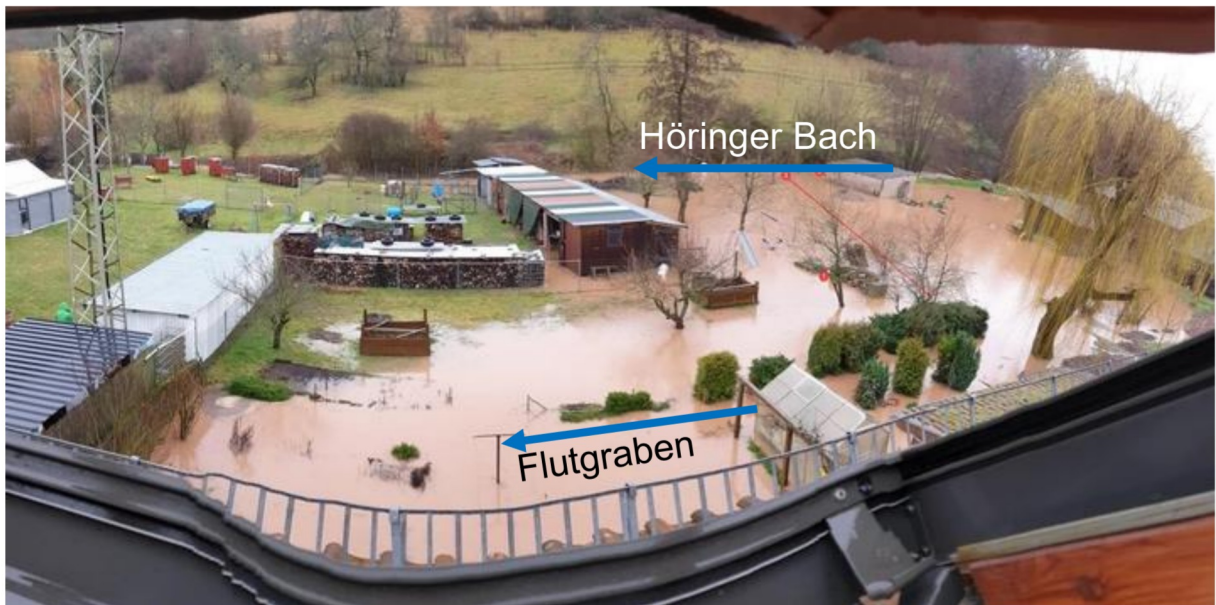
Abbildung 42: Schadensbild vom 04.01.2022, Grundstücke Hauptstraße 30,32,34
