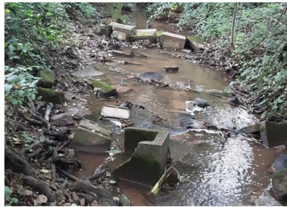
Abbildung 52: Höringer Bach, Geröll im Gewässer
