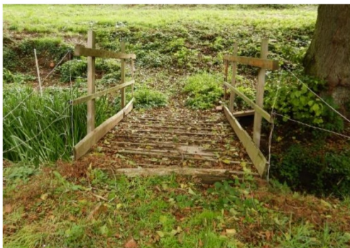
Abbildung 53: Höringer Bach, Brückenbauwerk
