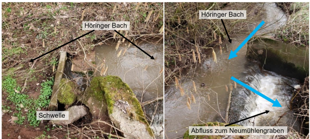
Abbildung 55: Wehrschwelle zwischen Höringer Bach und Neumühlengraben
