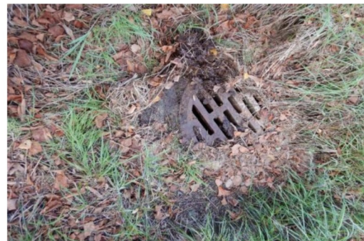
Abbildung 23: L387, Einlauf, Laub mit dem Fuß entfernt
