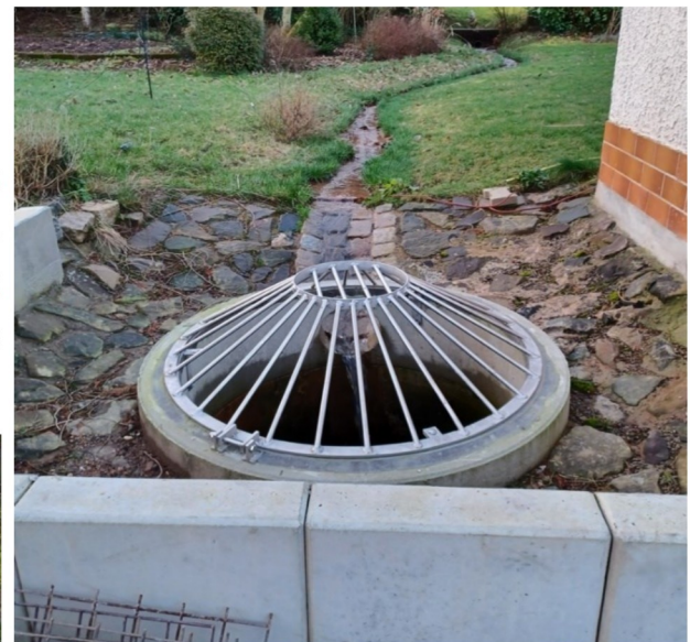
Abbildung 36: Grabensystem und Einlaufbauwerk
