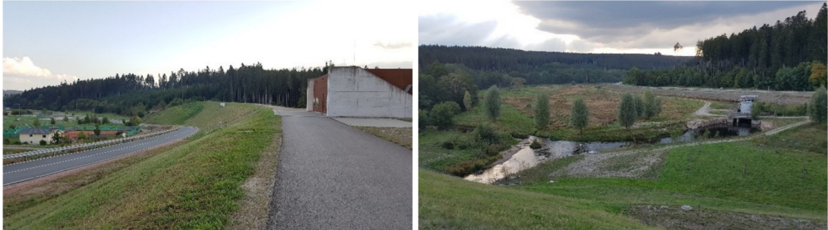
Abbildung 54: Beispiel Hochwasserrückhaltebecken Wolterdingen im Donau-Einzugsgebiet (max. Dammhöhe 18 m, Stauraum 4,7 Mio. m 3 , Bemessung auf ein 100-jährliches Hochwasser)
