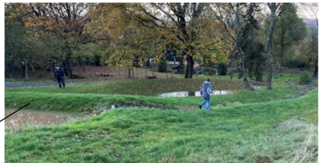
Abbildung 34: Mulden-Kaskaden
