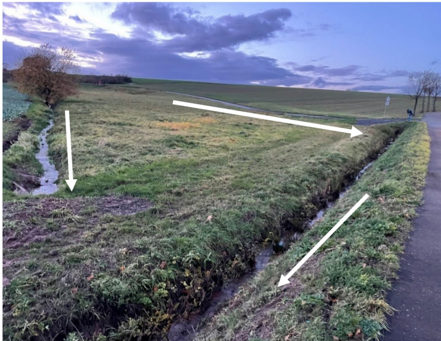
Abbildung 45: Entwässerungsgraben entlang der L 390 (Fließwege weiß)
