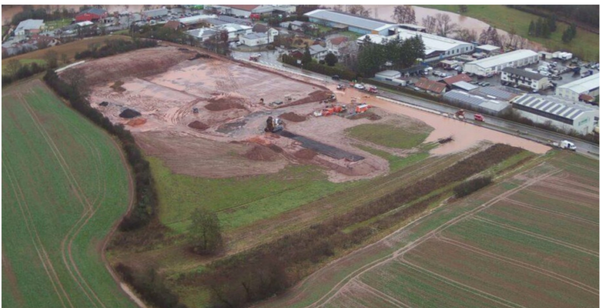
Abbildung 41: Gewerbegebiet "Schäferdelle" während der Bauphase (01/22)
