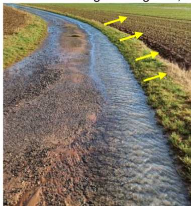
Abbildung 31: Maßnahmenvorschlag: Ableitung in die Fläche
