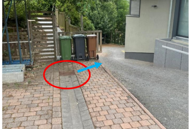
Abbildung 59: Straßeneinlauf (rot) und Fließwege (blau) in der Nähe des Anwesen (Nr.31)
