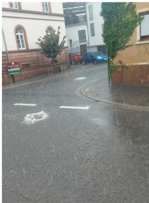
Abbildung 51: Überstau im Regenwasserkanal (Hauptstraße)
