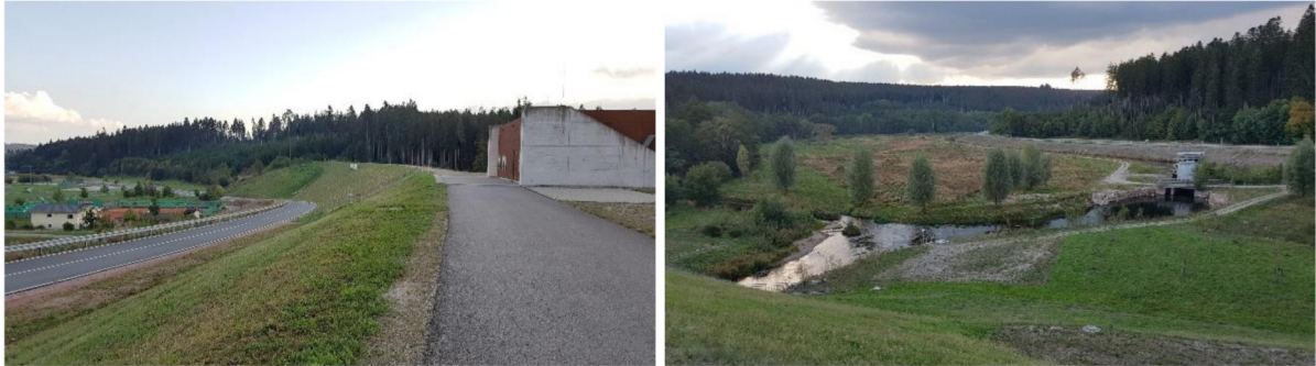
Abbildung 66: Beispiel Hochwasserrückhaltebecken Wolterdingen im Donau-Einzugsgebiet (max. Dammhöhe 18 m, Stauraum 4,7 Mio. m 3 , Bemessung auf ein 100-jährliches Hochwasser)
