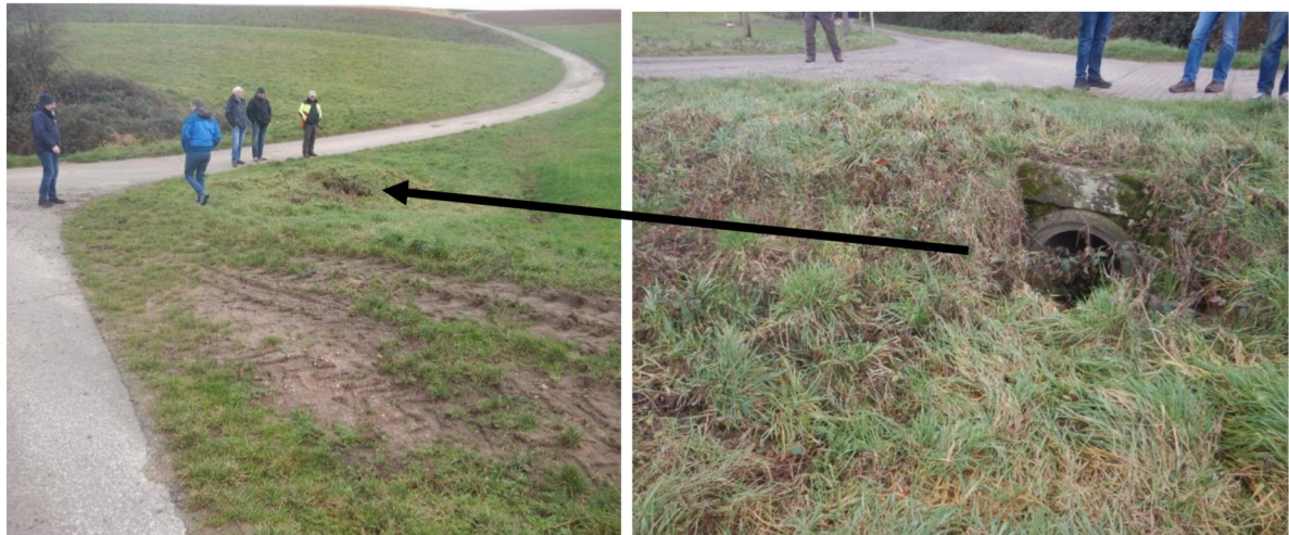
Abbildung 26: Maßnahmenvorschlag Rückhalt, bestehender Durchlass
