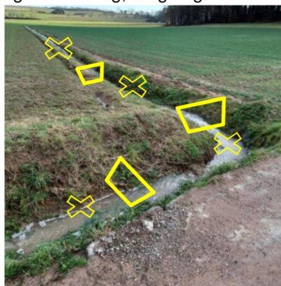
Abbildung 31: Maßnahmenvorschlag: Ableitung in die Fläche
