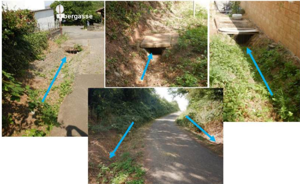
Abbildung 152: Obergasse, Gräben mit Einlaufbauwerken
