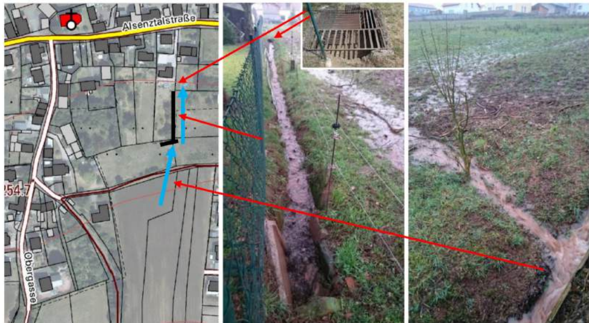
Abbildung 157: Außengebiet Obergasse, Oberflächenentwässerung
