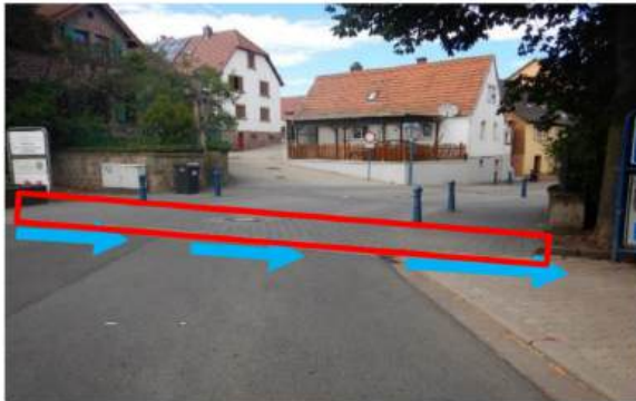
Abbildung 14: vorgeschlagene Straßenaufpflasterung (roter Bereich) mit Rampenschwellensteinen, rechts Beispiel.
