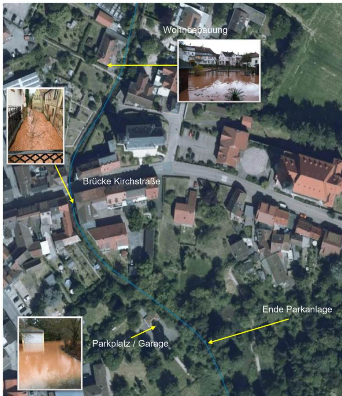
Abbildung 48: Überflutungsgefährdete Bereiche Teilabschnitt 1
