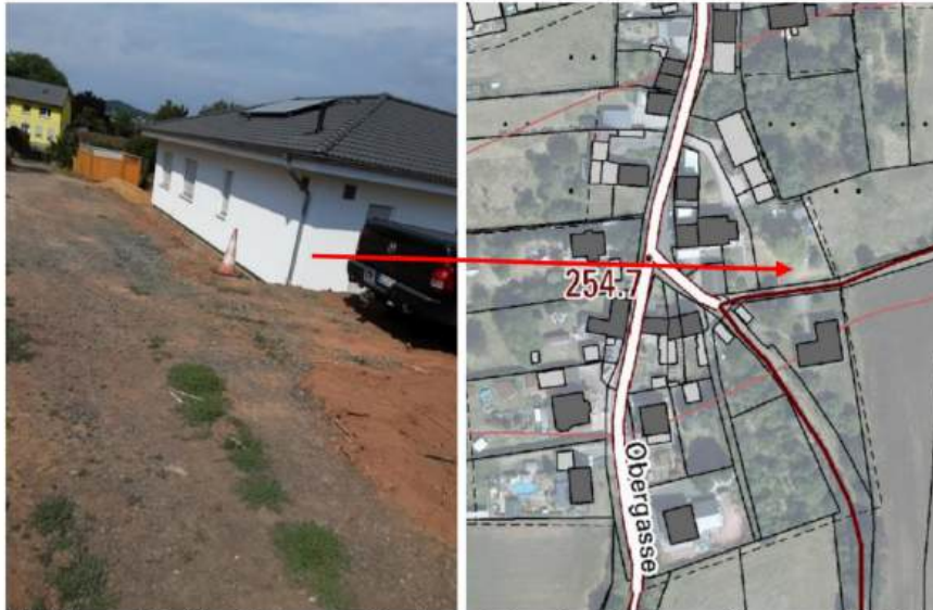
Abbildung 156: Überflutungsgefährdetes Gebäude Obergasse Übergang Feldweg
