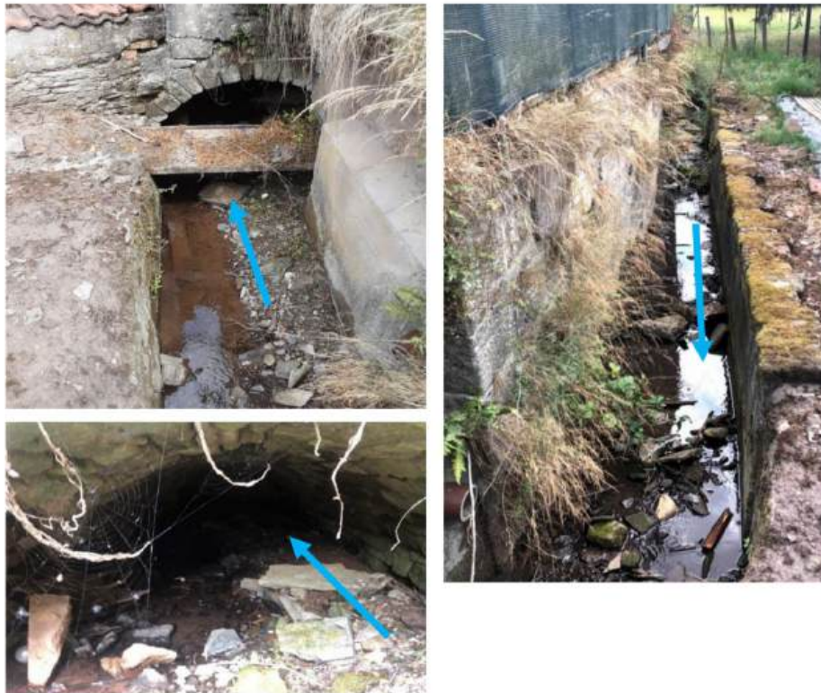
Abbildung 105: Fließwege (blau), Engstelle und Verrohrung
