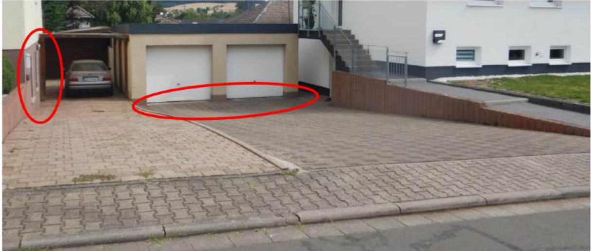
Abbildung 121: Potenziell gefährdete Stellen
