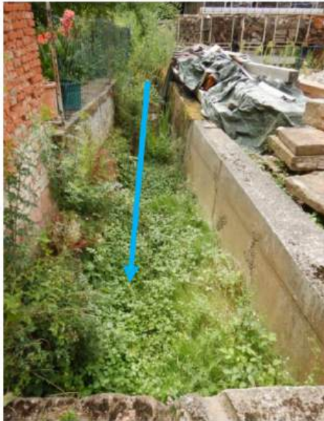
Abbildung 136: Gewässerabschnitt vor der Verrohrung
