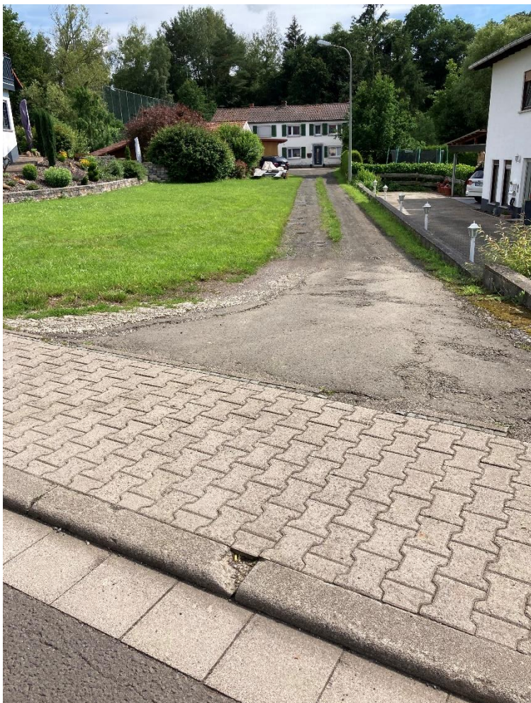
Abbildung: Erschließungsweg (Parzellen 475/14 und 475/15) aus Richtung Gienanthstraße (L 392) mit Blick auf das Anwesen Gienanthstraße 28, Parzelle 464/2.
