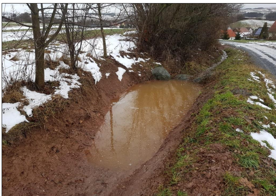
Abb. 20: Beispiel für eine tropfenförmige Aufweitung einer mit Natursteinen bewehrten Abflussrinne (Quelle: UP&B)
