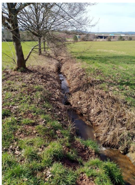
Wasserführender Graben auf Flurstück 1917, eigene Aufnahme BBP 03/2023
