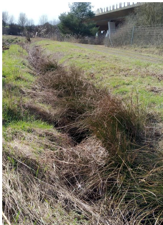
Entwässerungsgraben auf dem Flurstück 1966 in Blickrichtung Westen, eigene Aufnahme BBP 03/2023
