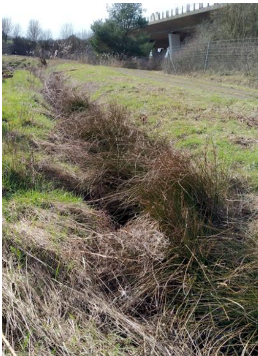
Entwässerungsgraben auf dem Flurstück 1966 in Blickrichtung Westen (Quelle: eigene Aufnahme am 16.03.2023)
