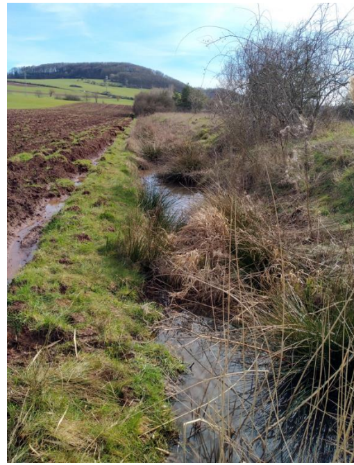
Entwässerungsgraben auf dem Flurstück 1919 in Blickrichtung Süden (Quelle: eigene Aufnahme am 16.03.2023)
