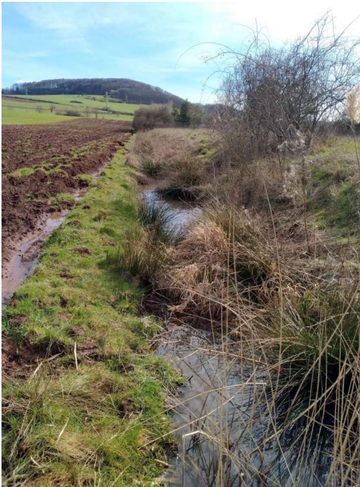
Entwässerungsgraben auf dem Flurstück 1919 westlich des Plangebiets in Blickrichtung Süden (Quelle: eigene Aufnahme am 16.03.2023)
