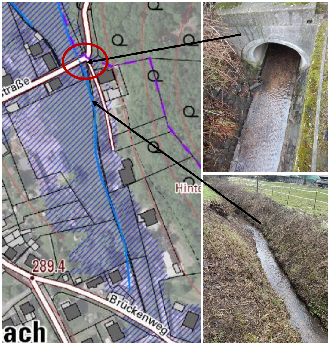
Abbildung 42: Gonbach, Durchlass Waldstraße (rot)
