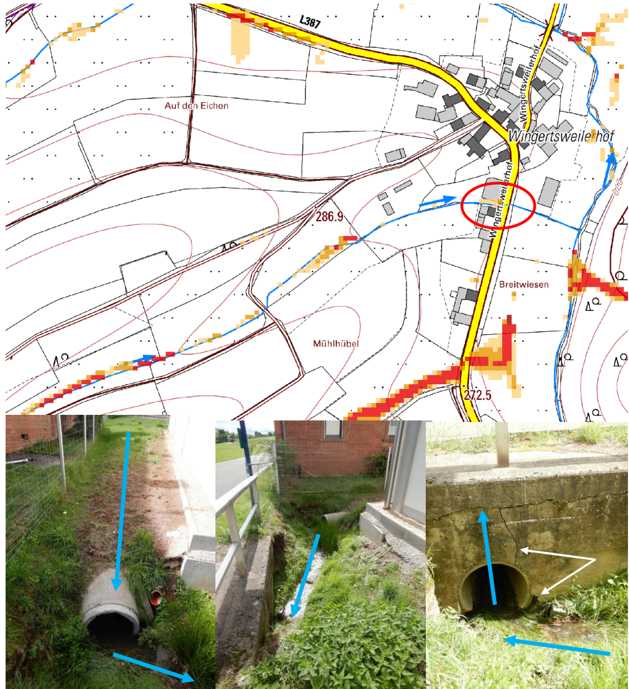
Abbildung 58: Wingerstweilerhof, Verrohrungen im bebauten Bereich (Fließwege blau, Schäden weiß)
