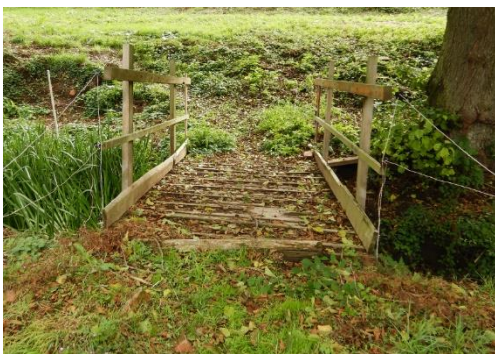
Abbildung 53: Höringer Bach, Brückenbauwerk
