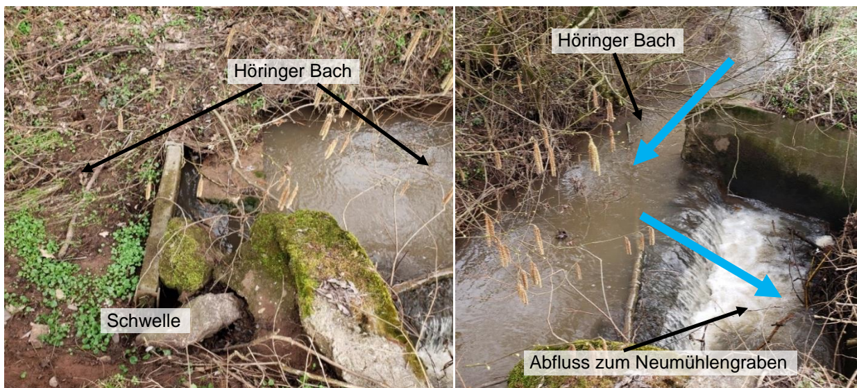
Abbildung 55: Wehrschwelle zwischen Höringer Bach und Neumühlengraben
