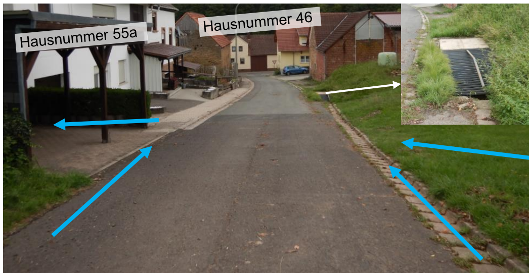
Abbildung 19: Entwässerung innerhalb der Hauptstraße (Fließwege blau)
