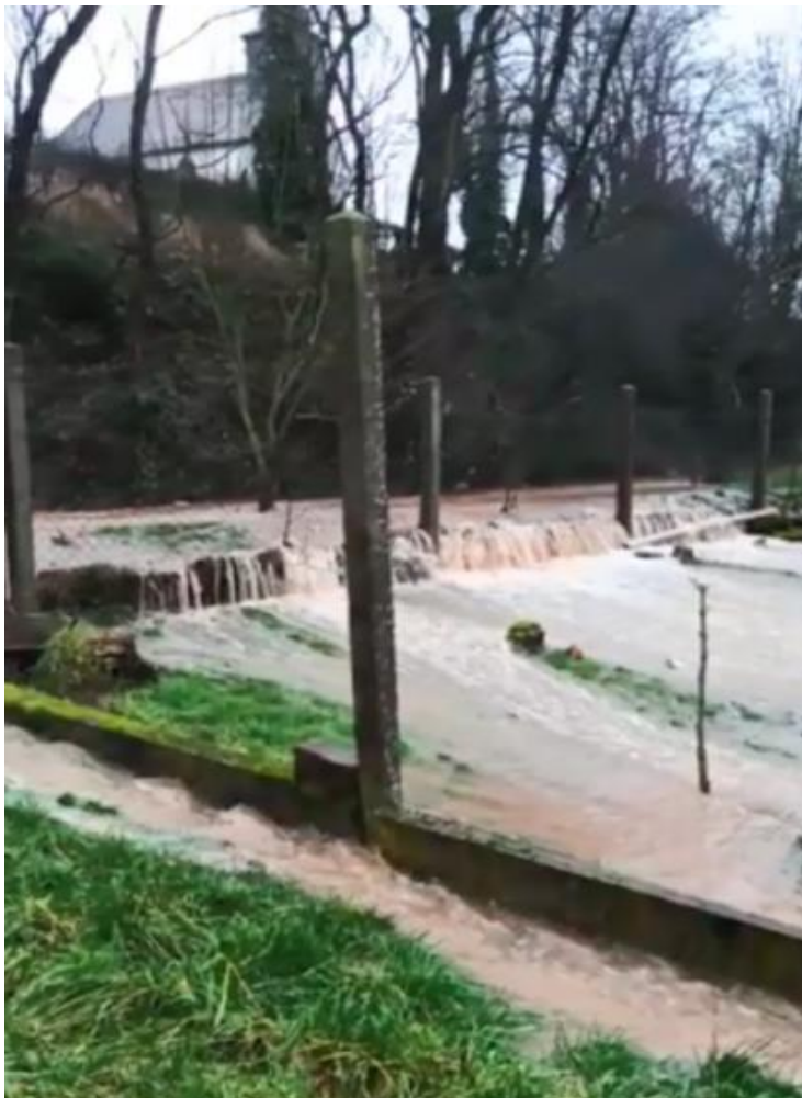
Abbildung 43: Höringer Bach am 04.04.2022 (Unterhalb der Kirche)
