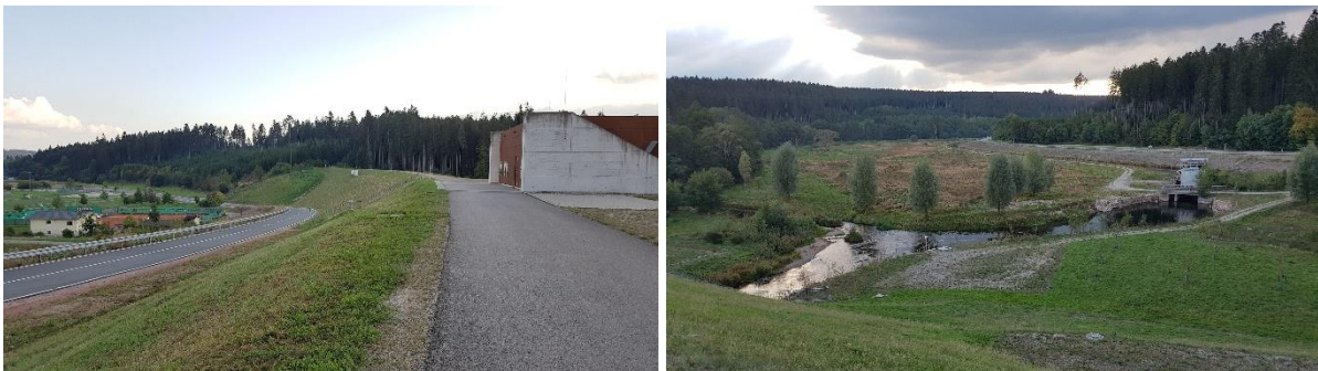
Abbildung 65: Beispiel Hochwasserrückhaltebecken Wolterdingen im Donau-Einzugsgebiet (max. Dammhöhe 18 m, Stauraum 4,7 Mio. m 3 , Bemessung auf ein 100-jährliches Hochwasser)
