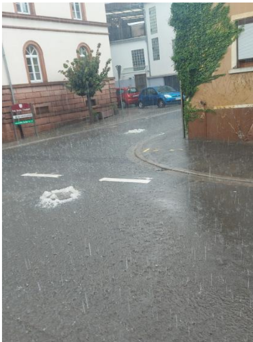
Abbildung 51: Überstau im Regenwasserkanal (Hauptstraße)
