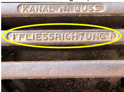
Abbildung 43: Bergeinlauf, Fließrichtung
