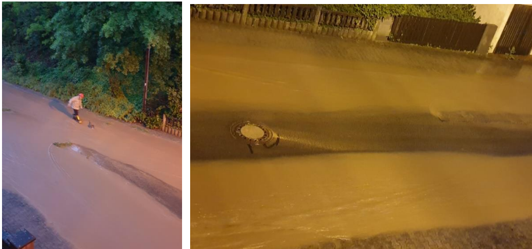
Abbildung 19: Am Schimmelberg, Oberflächenwasser und Schlamm im Straßenbereich
