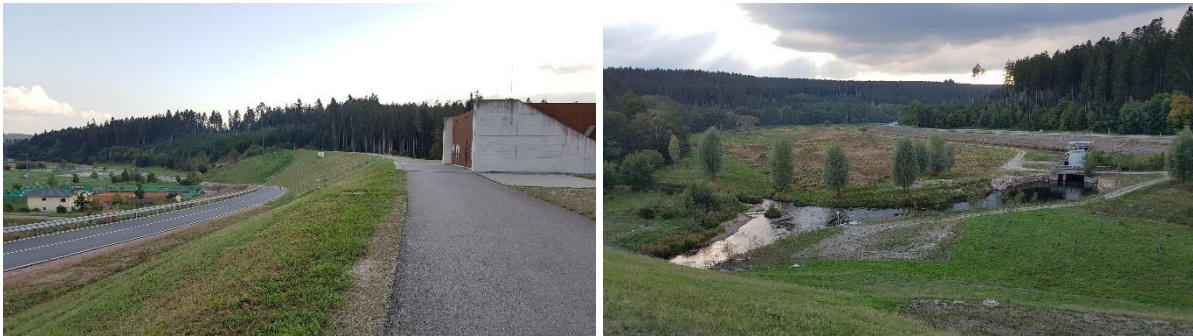
Abbildung 66: Beispiel Hochwasserrückhaltebecken Wolterdingen im Donau-Einzugsgebiet (max. Dammhöhe 18 m, Stauraum 4,7 Mio. m 3 , Bemessung auf ein 100-jährliches Hochwasser)
