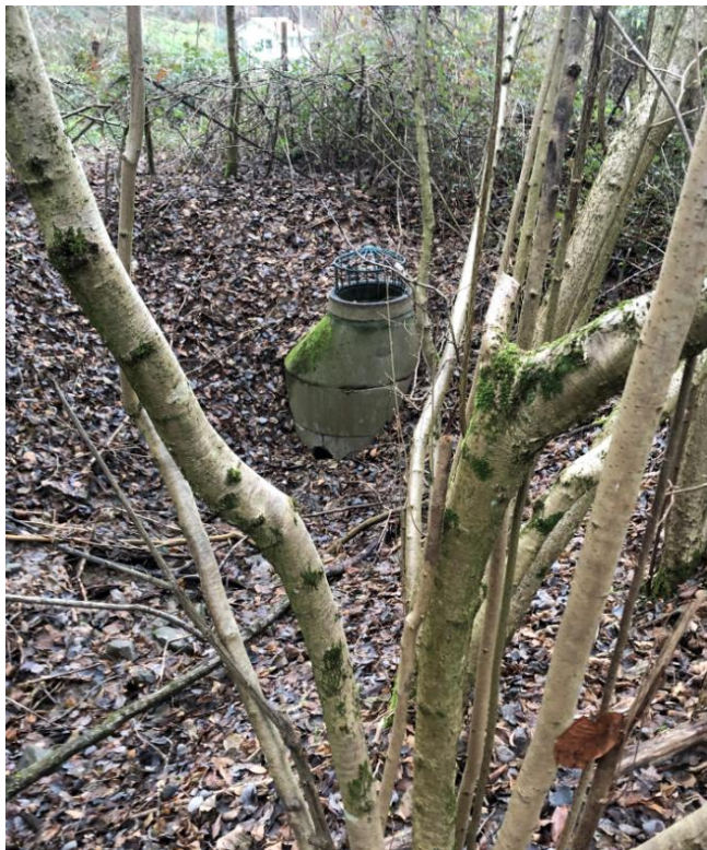
Abbildung 12: Graben mit Drossel und Notüberlauf
