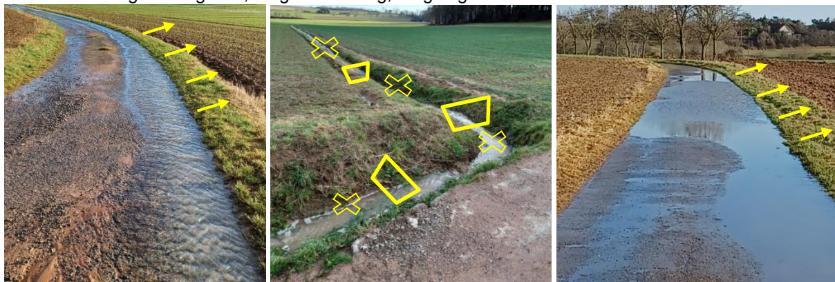
Abbildung 31: Maßnahmenvorschlag: Ableitung in die Fläche
