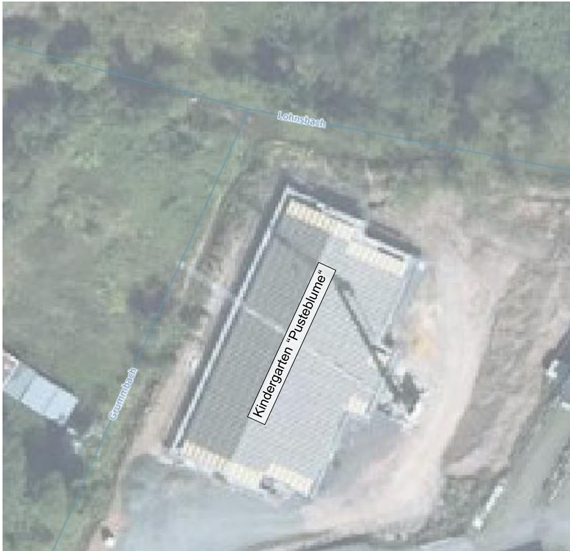
Abbildung 35: Mündung des Grumbach in den Lohnsbach
