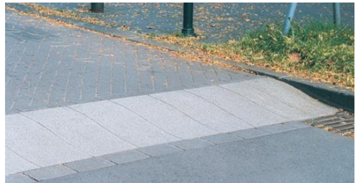
Abbildung 14: vorgeschlagene Straßenaufpflasterung (roter Bereich) mit Rampenschwellensteinen, rechts Beispiel.
