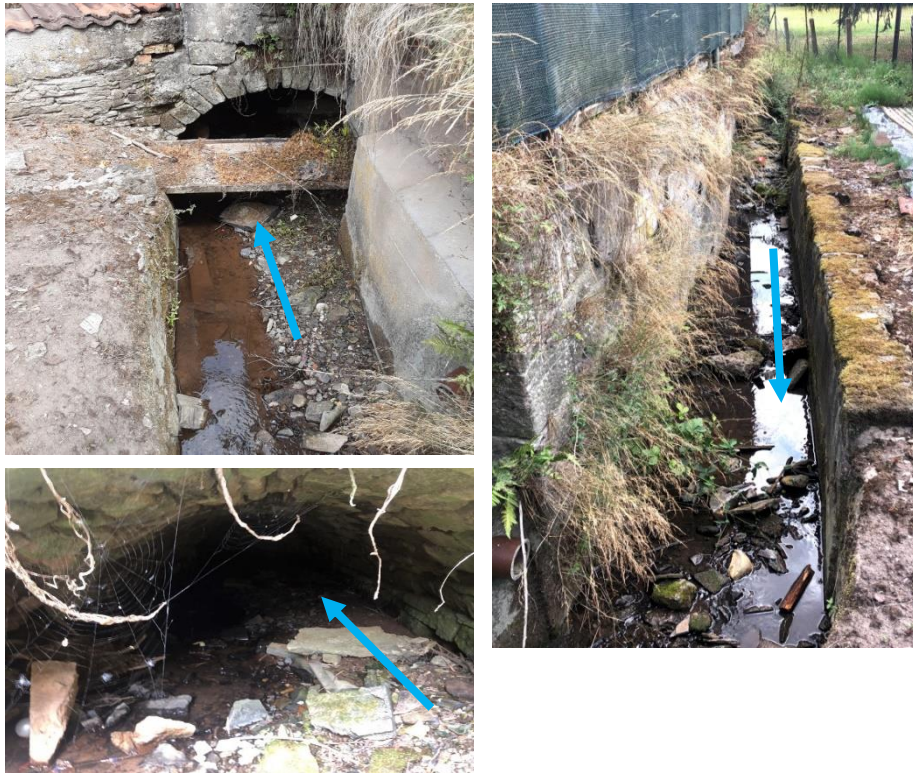
Abbildung 105: Fließwege (blau), Engstelle und Verrohrung
