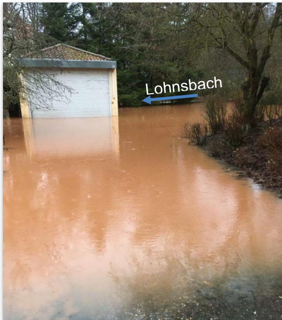
Abbildung 50: Überflutungsbereich Garage Lohnsbachpark
