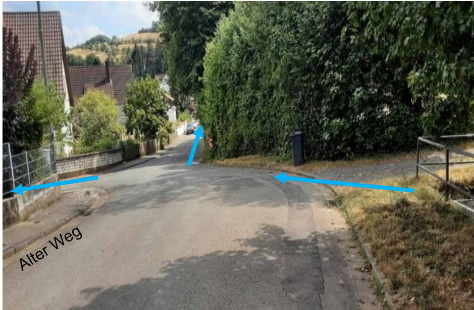
Abbildung 94: Fließwege bei Überlastung der Verrohrung
