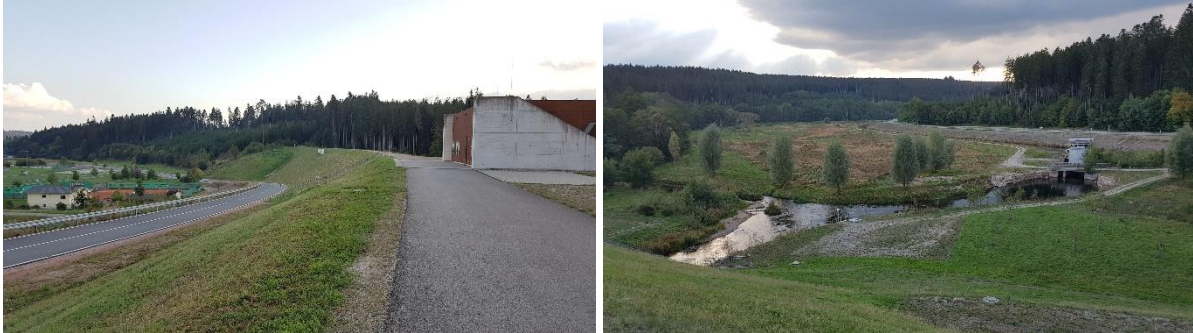
Abbildung 164: Beispiel Hochwasserrückhaltebecken Wolterdingen im Donau-Einzugsgebiet (max. Dammhöhe 18 m, Stauraum 4,7 Mio. m 3 , Bemessung auf ein 100-jährliches Hochwasser)
