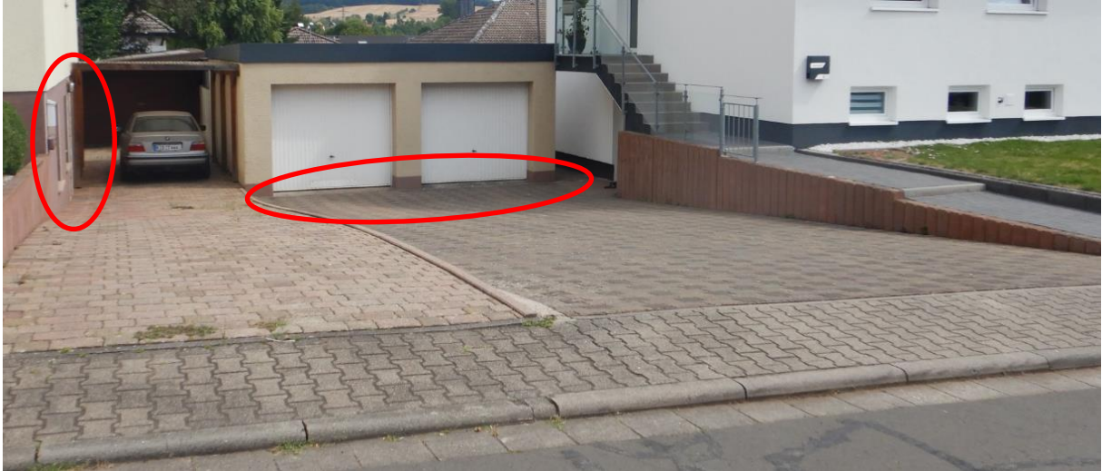
Abbildung 121: Potenziell gefährdete Stellen
