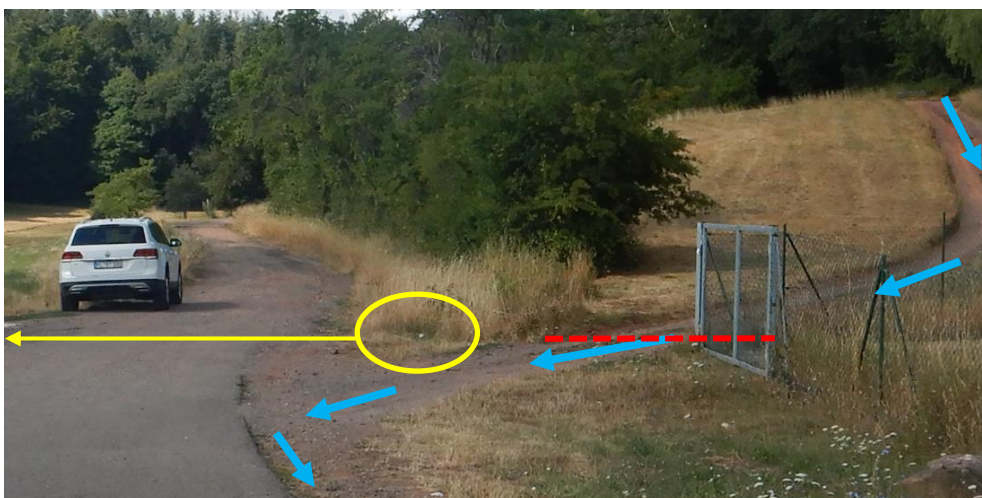
Abbildung 73: Feldweg, Fließweg (blau), Durchlass (gelb), Maßnahmen (rot)
