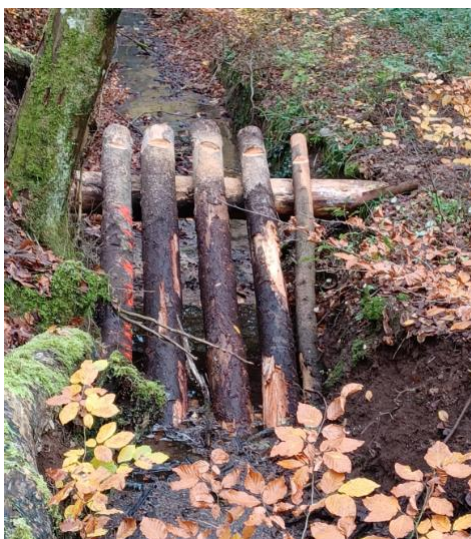
Abbildung 100: Treibgutfänger im Gewässer
