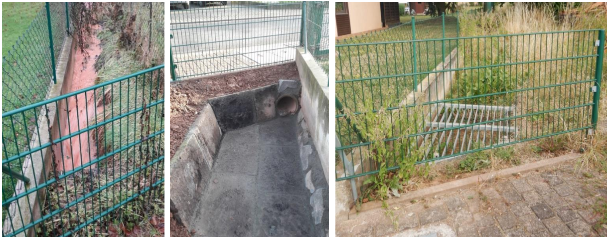
Abbildung 147: Maßnahmen am Einlassbauwerk (links Ursprungszustand, Mitte Baumaßnahmen, rechts aktueller Zustand).
