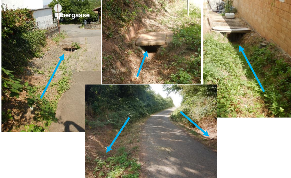
Abbildung 152: Obergasse, Gräben mit Einlaufbauwerken
