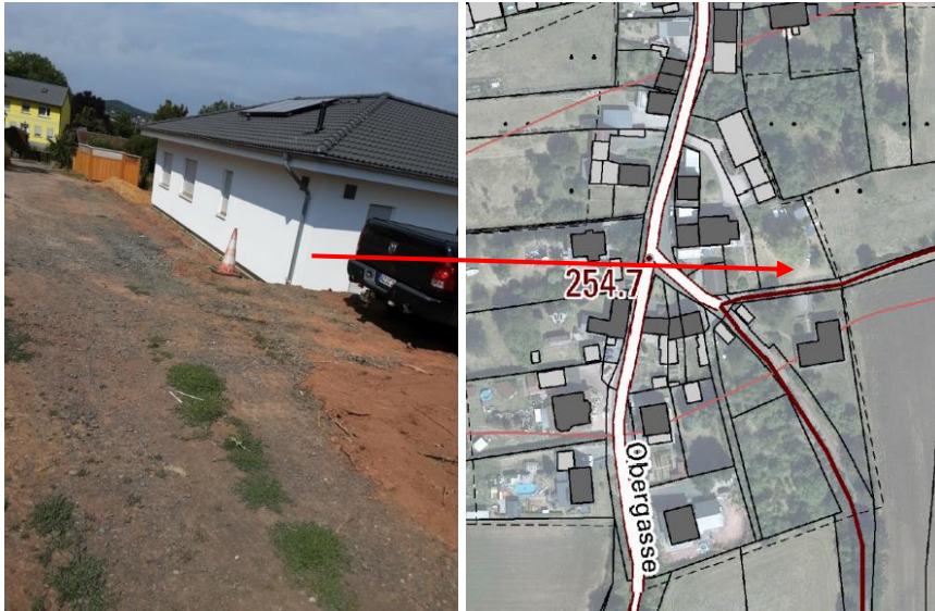
Abbildung 156: Überflutungsgefährdetes Gebäude Obergasse Übergang Feldweg
